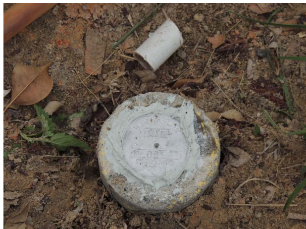
Implantação dos marcos de apoio. (M2)
