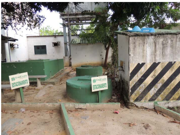
Vista de casa de bombas e poços.
